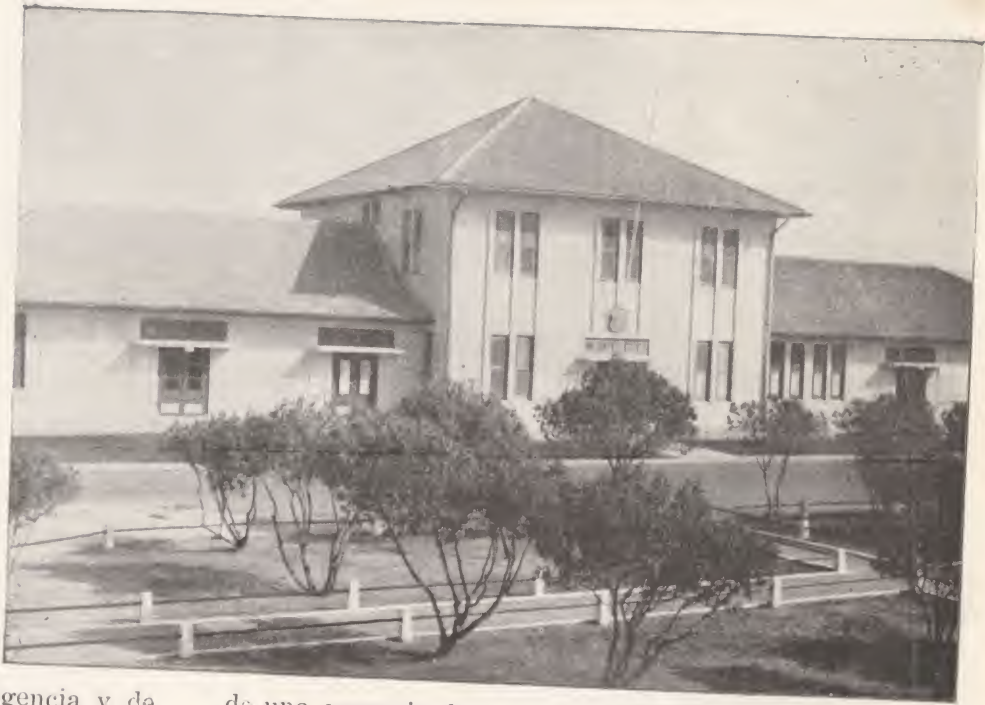
Edificio en donde se encuentra el Despacho del Teniente Gobernador, el Departamento de Finanzas y otras oficinas del Gobierno
